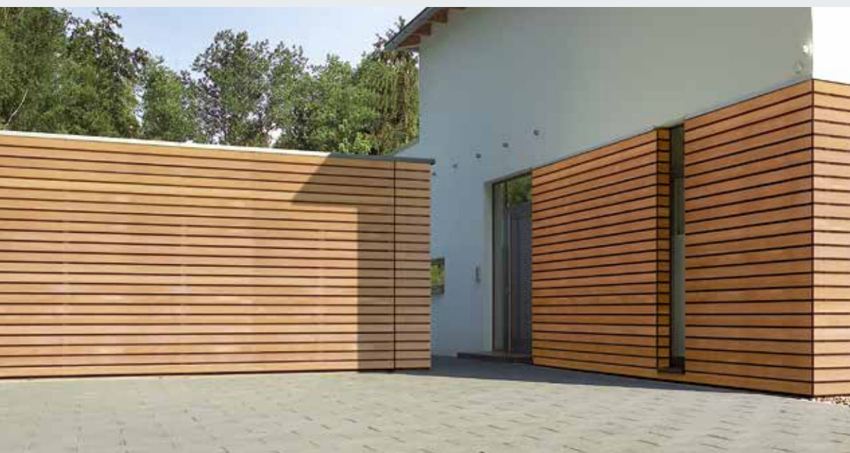
Parement par l'utilisateur avec panneaux en bois
