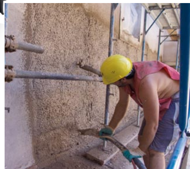
Projection d'enduit extérieur
