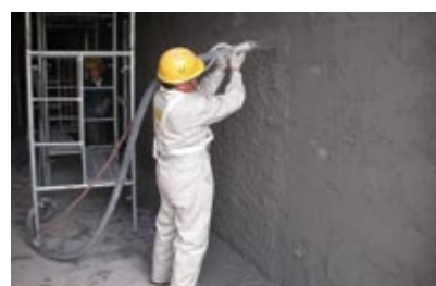
Projection d'enduit intérieur
