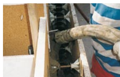
Remplissage de parpaings
