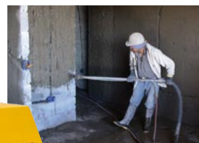
Projection d'enduit intérieur
