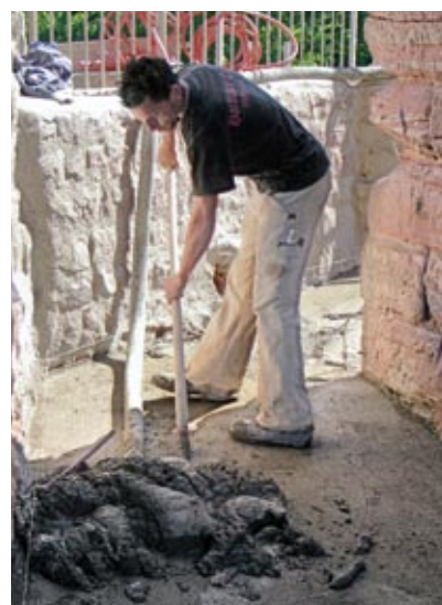
Pompage de béton fin jusqu'à 10 mm
