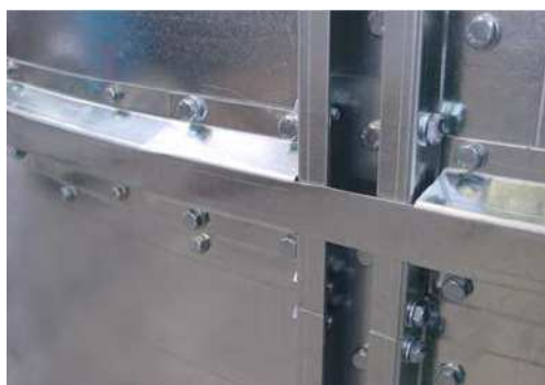
Renforts verticaux et horizontaux avec connecteurs
