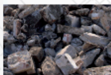
débris de démolition
