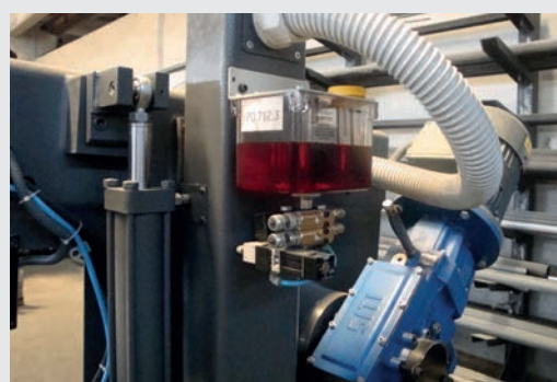
Système de refroidissement
