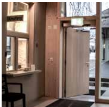
Voie de fuite / Sortie de secours
