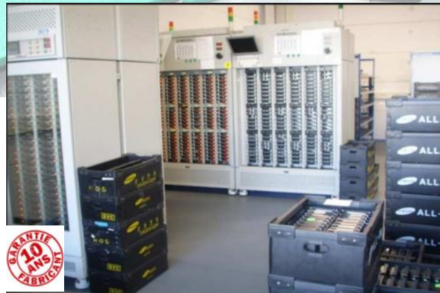
Salles de serveurs.
