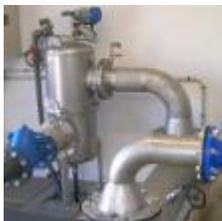
**Eau potable.** Ces modèles sont disponibles en version certifiée ACS pour une utilisation sur les réseaux d'eau potable. Ils peuvent être utilisés en filtration finale ou en protection de systèmes d'ultra-filtration.
