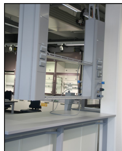
Exemple de colonnes fixées au plafond avec 2 niveaux d'étagères
