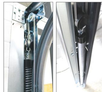
Ce doublé permet aussi, en cas de rupture de l'un d'entre eux, de maintenir la porte dans sa position grâce au ressort restant.
