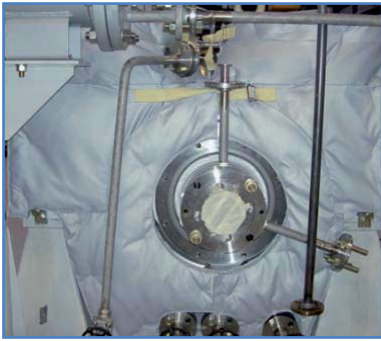
Traitement acoustique de corps de pompes
