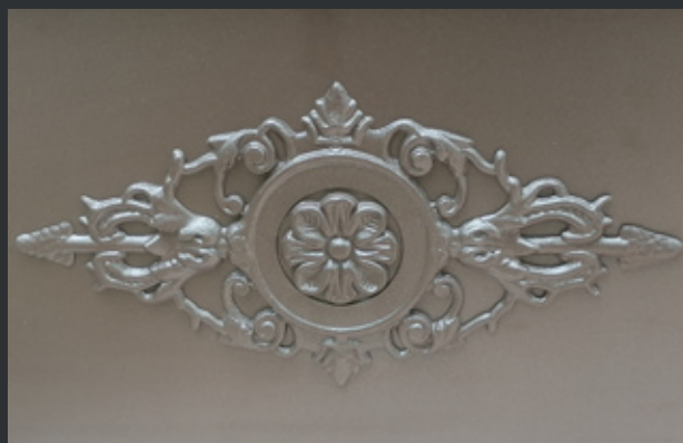
Soubassements supportant des décors en aluminium moulé.
