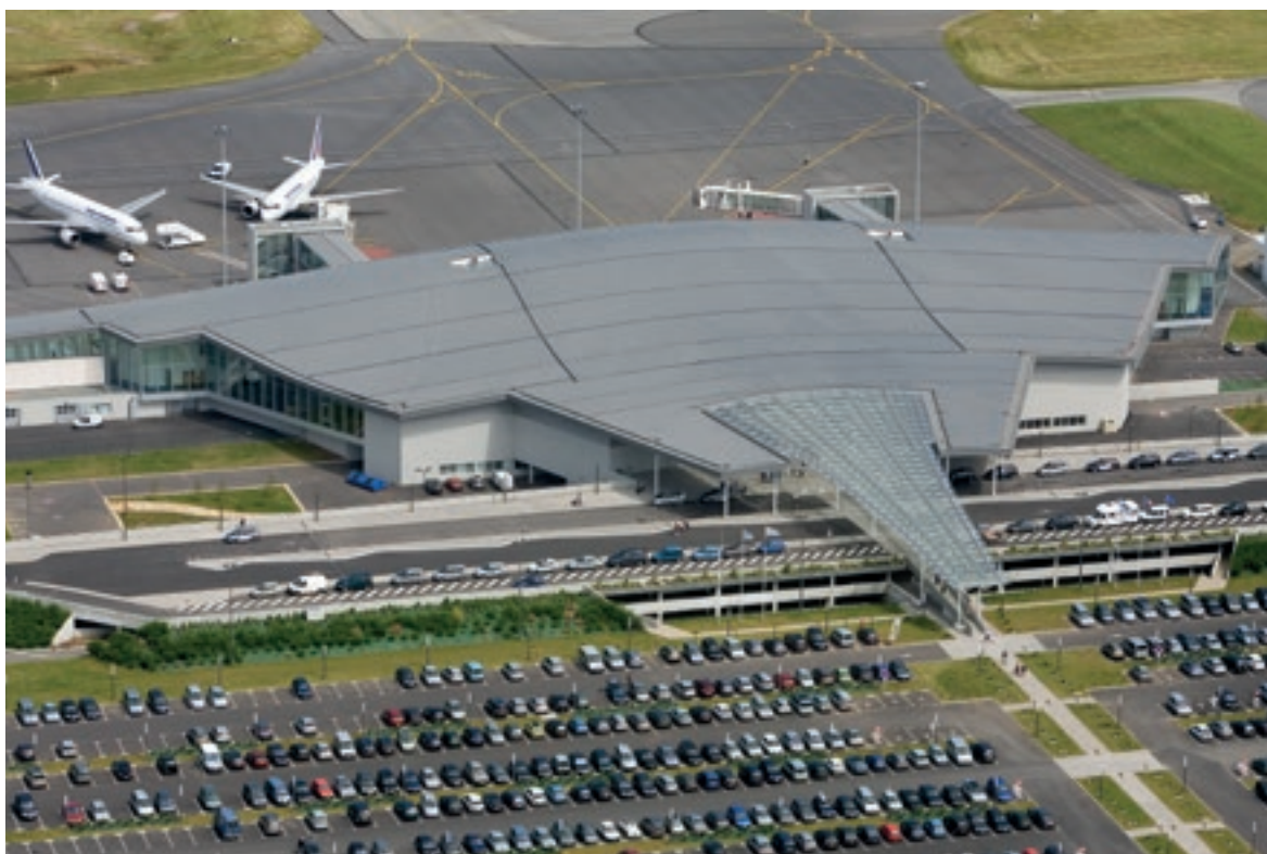
Aéroport, Brest (France) - Architecte : Christian Weinmann & Denis Dietschy - Drlw architectes - Entreprise : Bihannic SA
