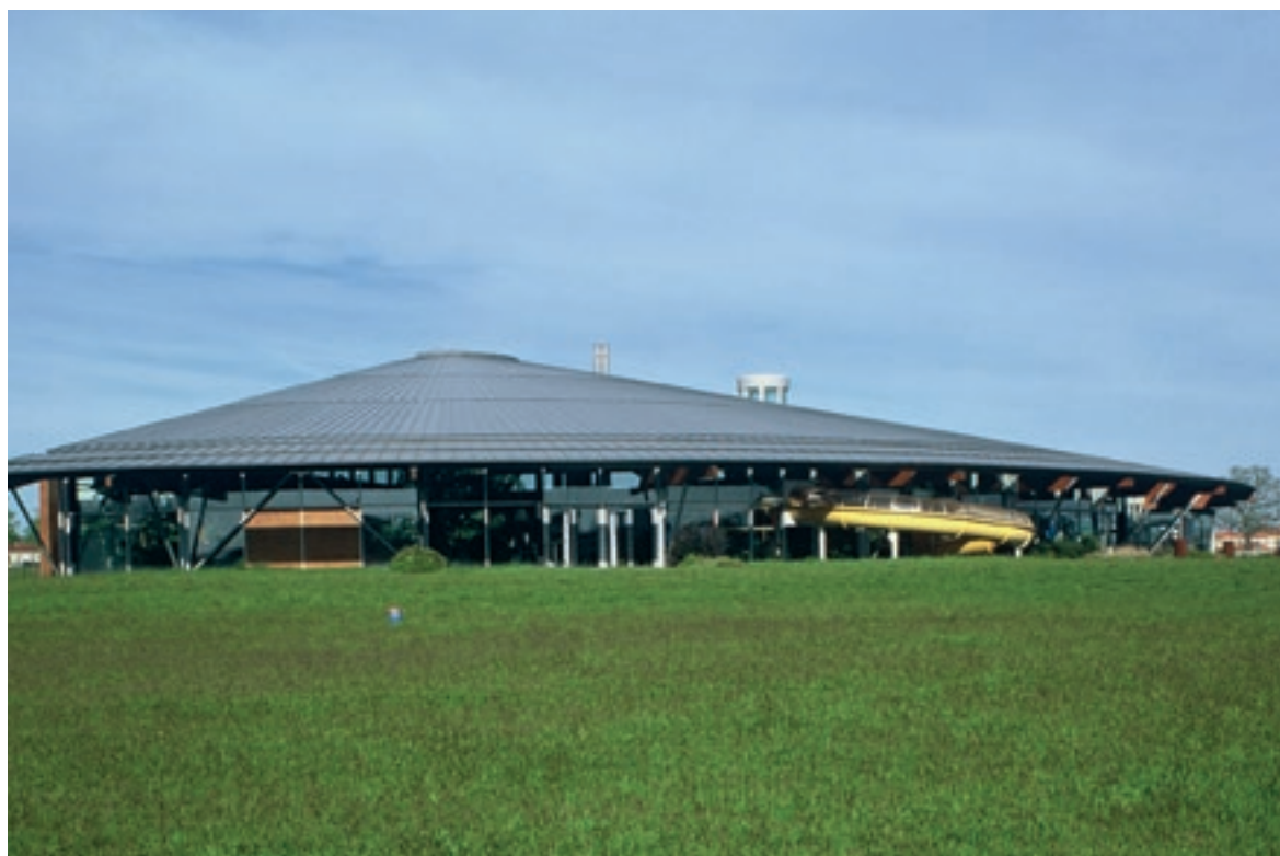
Piscine, Les Herbiers (France) - Architecte : Durand/Menard/Thibault - Entreprise : Raimond
