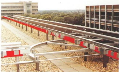
7. Ascenseur extérieur d'entretien avec des courbes-entonsnoirs et aiguillage.
