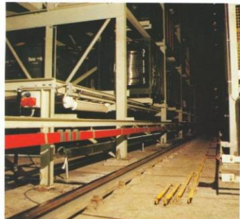
5. Installation de stockage chez VW Courant principal + courant de commande. Vitesse 200 mm/s.
