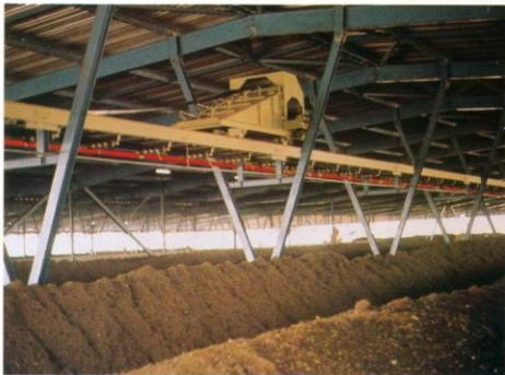
9. Installation de compost au Moyen-Orient. Températures élevées, très poussiéreuse, et humide.
