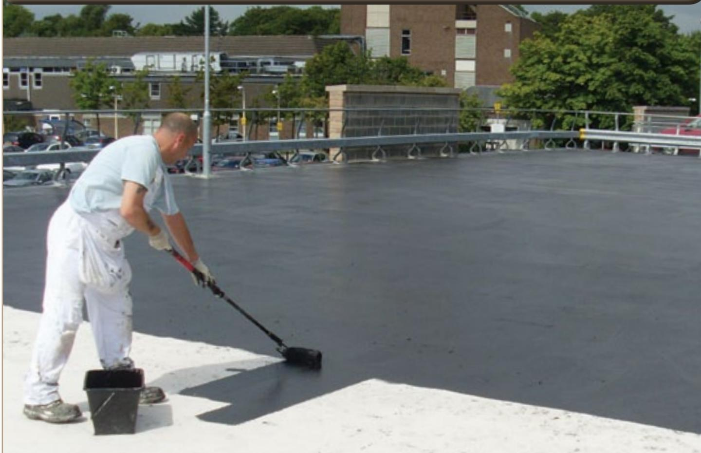
Peinture monocouche très résistante, idéale pour une application extérieure sur une surface en béton ou en bitume. Facile à appliquer à la brosse ou au rouleau, elle offre une résistance exceptionnelle à l'usure.
