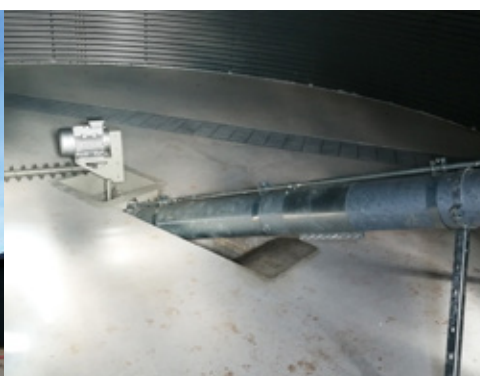
Cellules ronde : ventilation par lames ventilées, vis racleuse amovible, et reprise par vis
