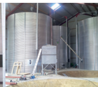
Montage de cellules rondes sur cônes béton
