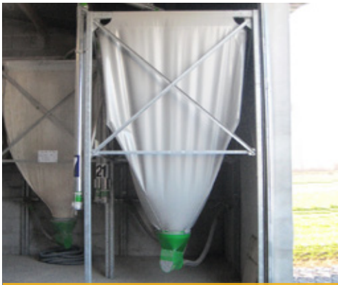
SILO TOILE AVEC REMPLISSAGE PNEUMATIQUE
