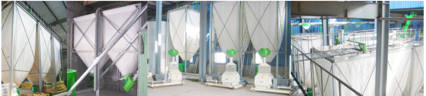
Silos toile sous passerelles
