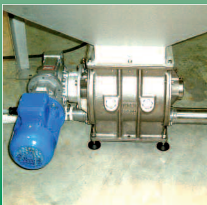
Écluse tout inox pour transfert pneumatique de granulés plastiques en sortie de silo de stockage
