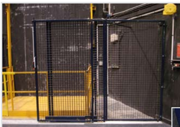
Protection grillagée mobile pour élévateur de charges
