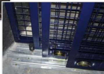
Protection grillagée mobile pour élévateur de charges
