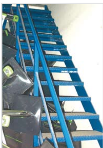
Escalier type industriel totalement métallique
