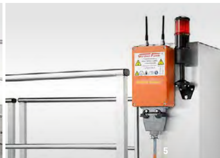
5 Avec la télécommande, le racleur de boue de fond semi-automatique ou entièrement automatique peut être commandé facilement.
