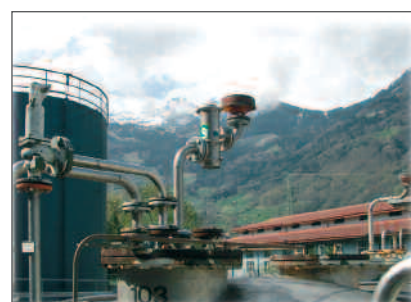
ELEVENT® « entrée d'air frais » sur un réacteur
