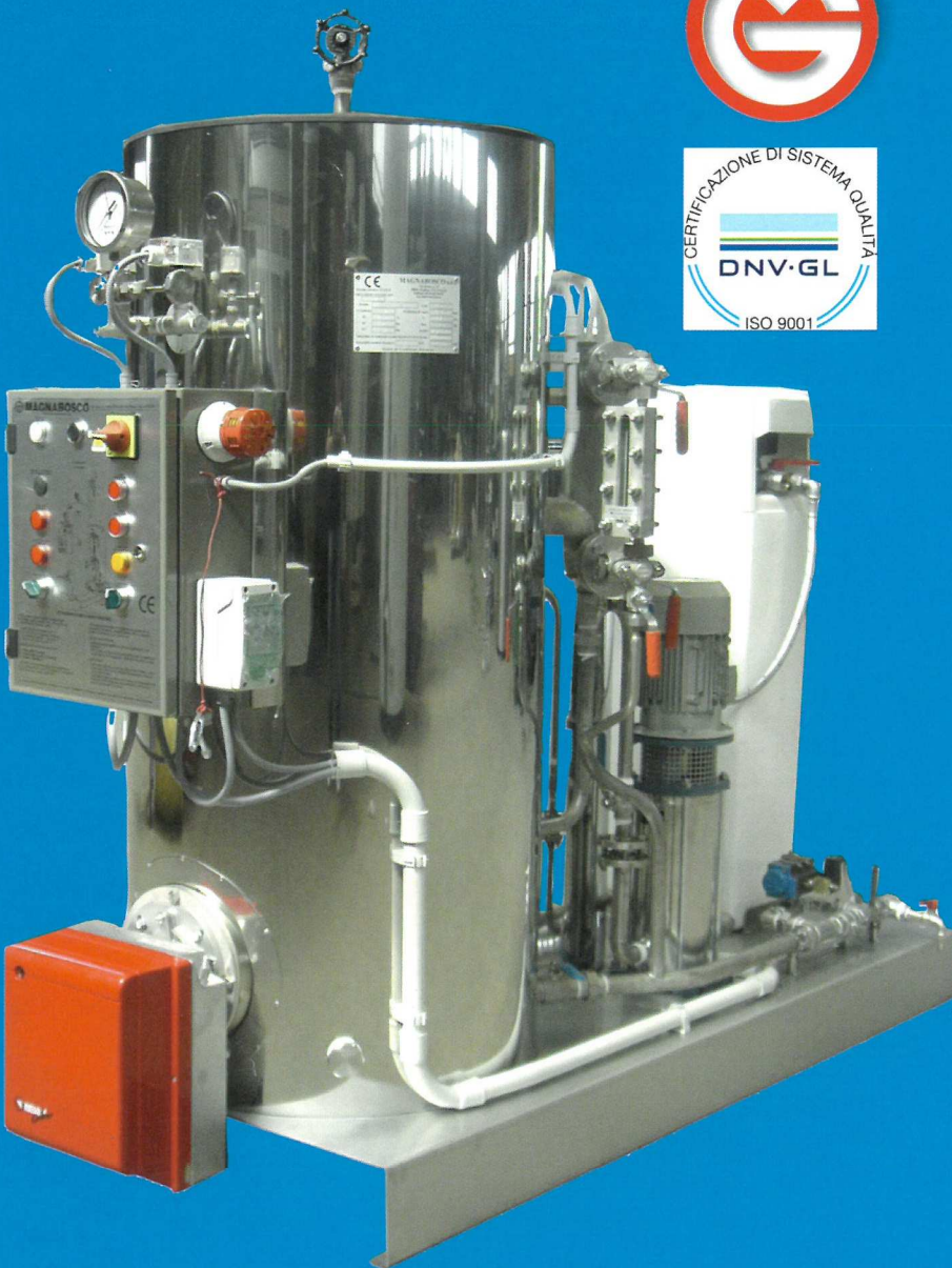
GVR 650 in AISI 316L con Economizzatore GVR 650 in AISI 316L with Economizer
