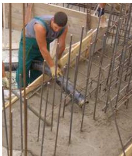
La P 718 refoule entre autres du béton fin jusqu'à une granulométrie de 32 mm.
