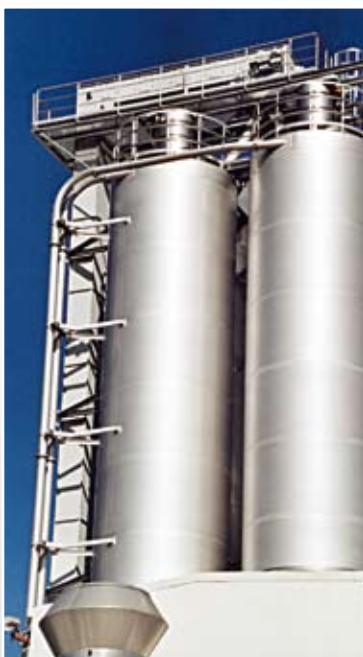
Stabile geschlossene Blechkonstruktion
