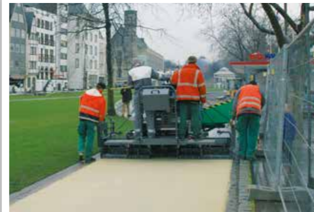
CONSTRUCTION DE CHEMINS EN ESPACES VERTS
