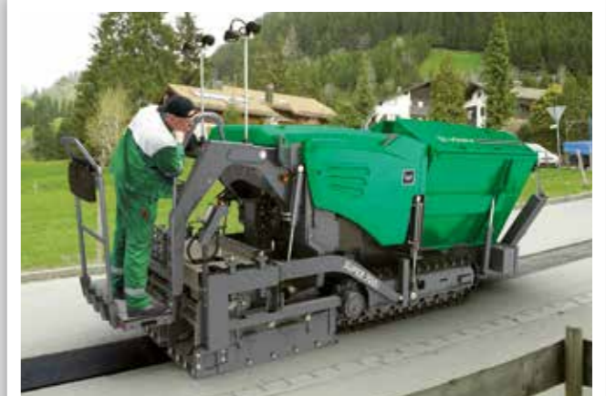
FERMETURE DE TRANCHÉES DE CANALISATION
