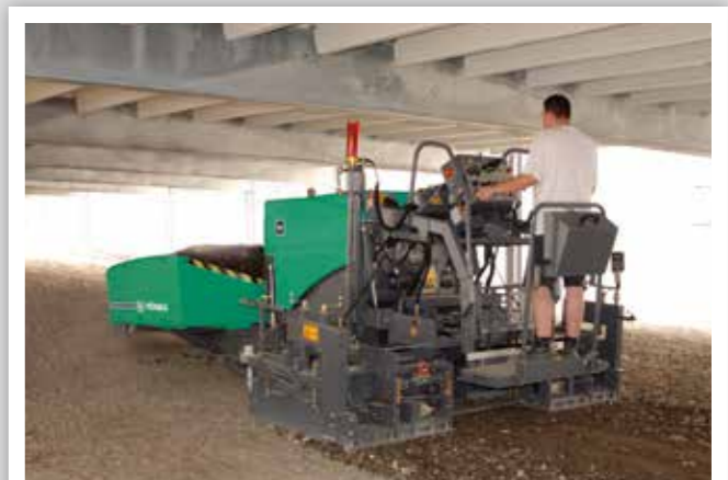
RÉALISATION DE L'ASSISE POUR UNE POSE DE PAVÉS
