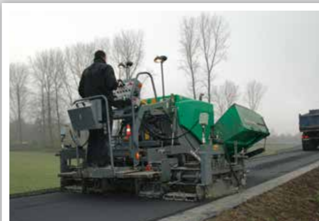
POSE D'ENROBÉ SUR DES DIGUES
