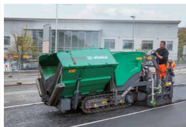
REMISE EN ÉTAT DE PETITES ROUTES COMMUNALES
