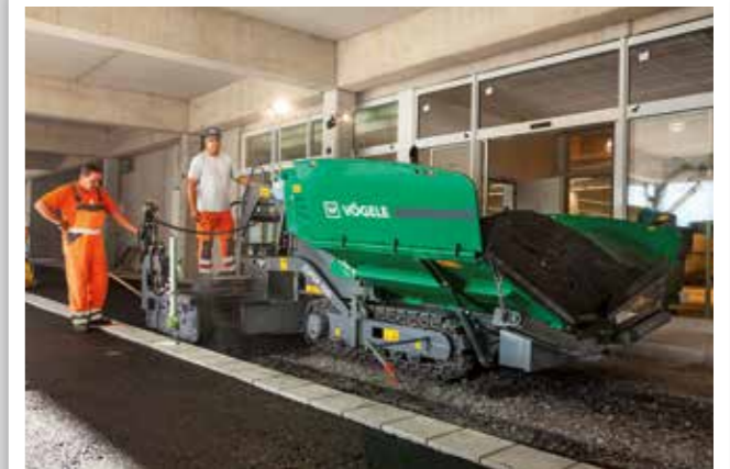
POSE D'ENROBÉ DANS DES HALLES INDUSTRIELLES
