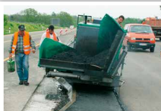
POSE D'ENROBÉ SUR LE TERRE-PLEIN CENTRAL D'AUTOROUTES
