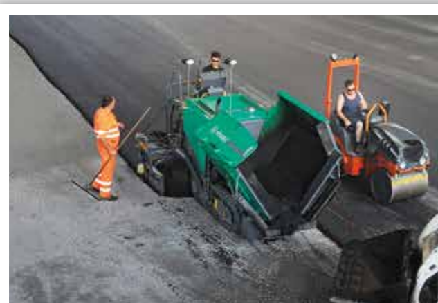
POSE D'ENROBÉ SUR DES TERRAINS DE SPORT
