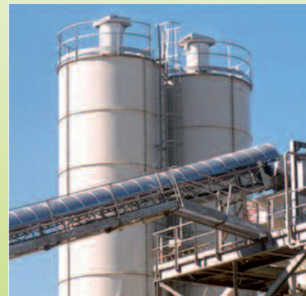
Filtre bridé en extérieur silo
