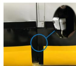
Contact de sécurité en partie basse du tablier : L'alimentation électrique se coupe si l'issue de secours est utilisée.
