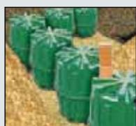
Les nombreux manchons positionnés sur Hercule et le set de jumelage permettent de relier facilement et durablement les réservoirs entre eux.
