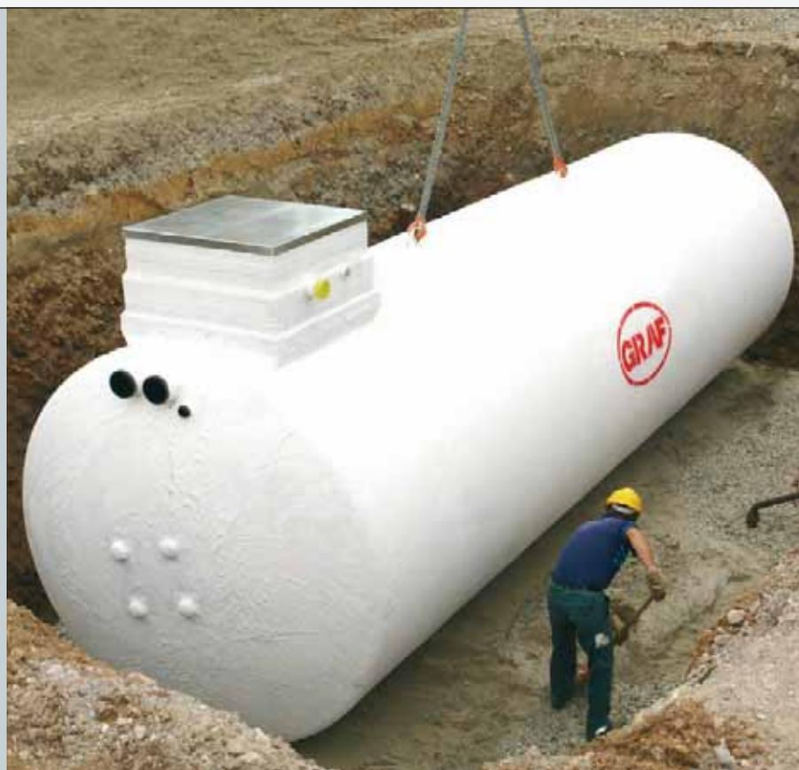
Résistant jusqu'à 35°C, revêtement intérieur plastique, extérieur bitumeux (DIN 6607).
