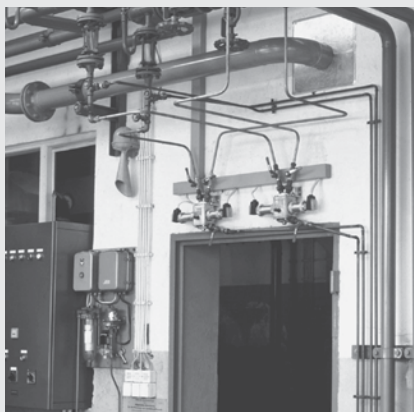
Surveillance de la présence de graisse et d'huile dans deux retours de condensats séparés
