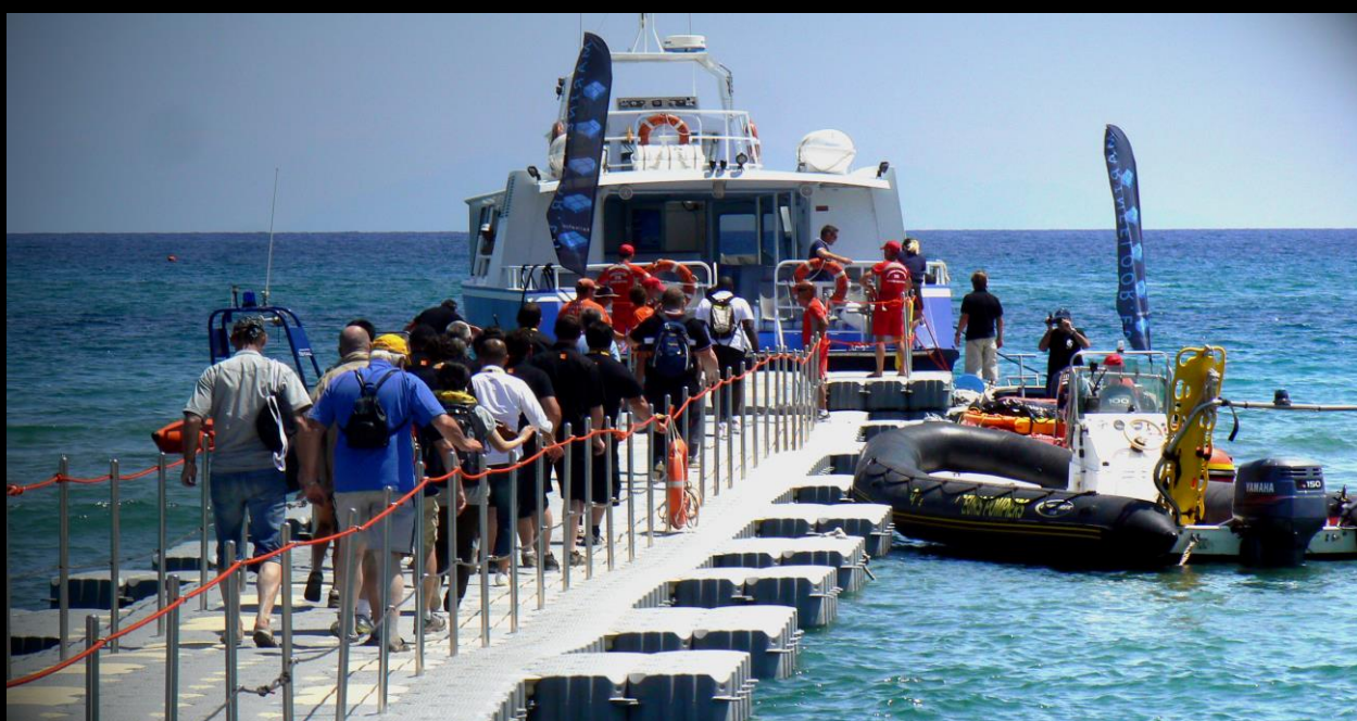
Appontement provisoire de 381 m 2 - Tour de France (Porto-Vecchio → Bastia) - 2013
