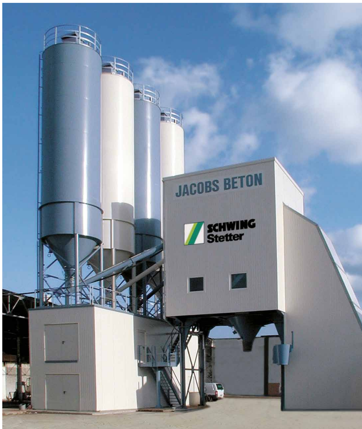
HN 3,0 avec malaxeur à double arbre, rendement de béton ferme : 127 m 3 /h.
