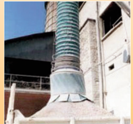
Chargement camion ouvert avec jupe anti-poussière
