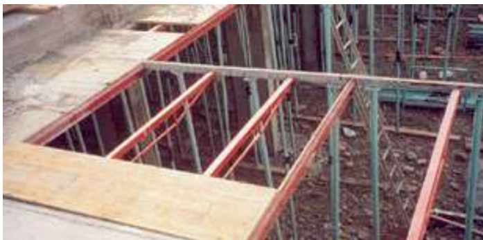
Desencofrado sin reapuntamiento / Un-formwork without props reinforcement / Re-coffrage sans étaieement
