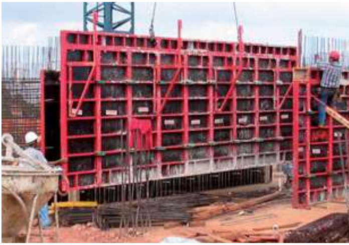
Manipulación de un muro de 24 m 2 .
