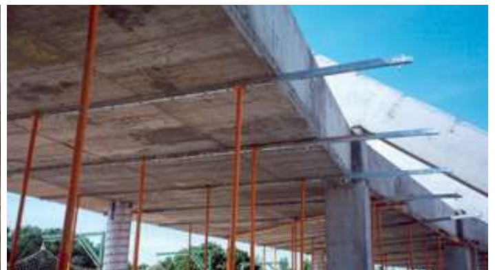
Planta apuntalada 2 m. de luz / Reinforced props floor 2 m. light / Étage étagée avec 2 m. de portée
