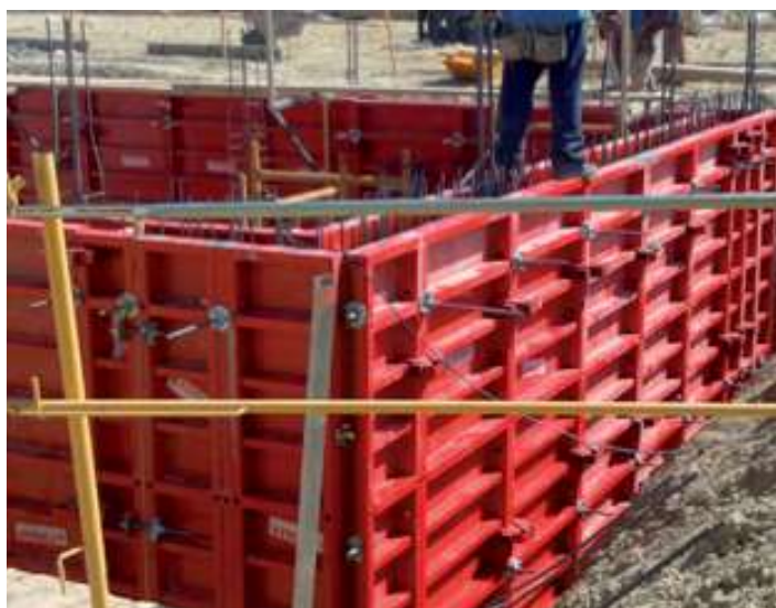
Muro a 2 caras para bodega soterrada.
