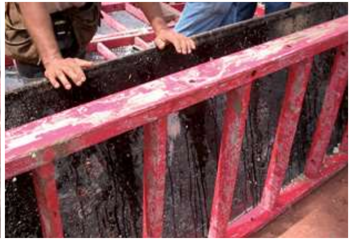
Cambio de tablero fenólico.
