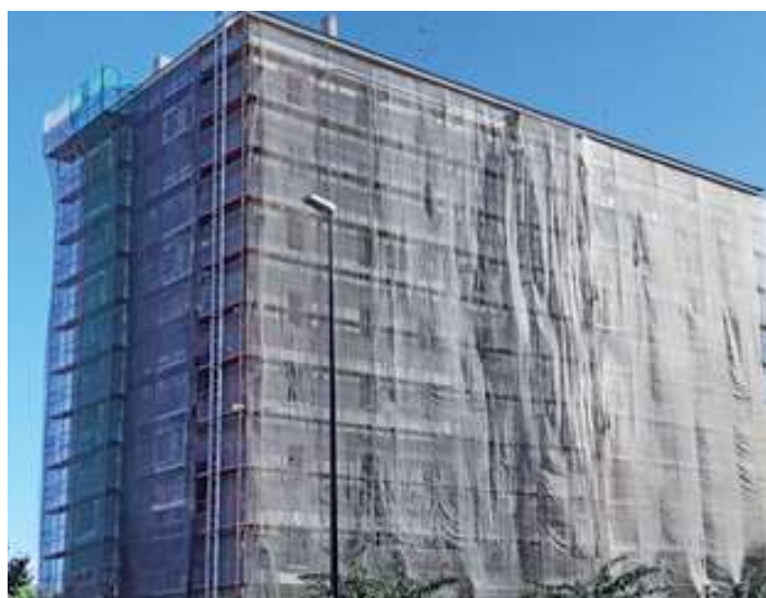
Fachada de andamio FER 48 haciendo esquina.
