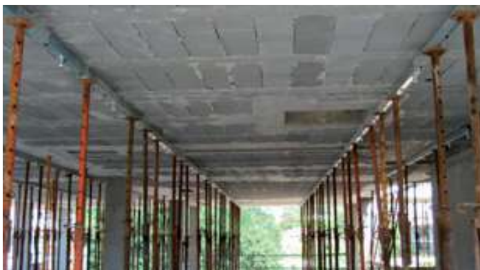
Planta apuntalada 2 m. de luz / Reinforced props floor 2 m. light / Étage étagée avec 2 m. de portée
