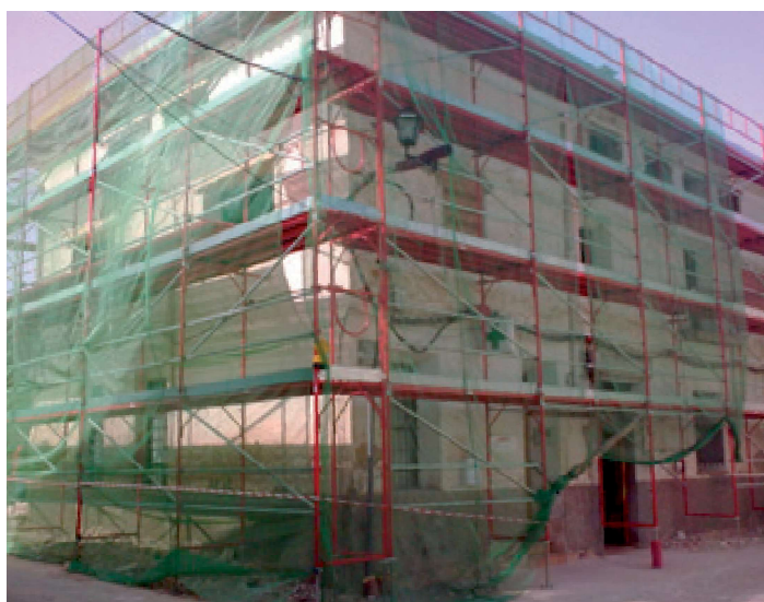
Fachada de andamio FER 48 de 1020 mm. haciendo esquina.
