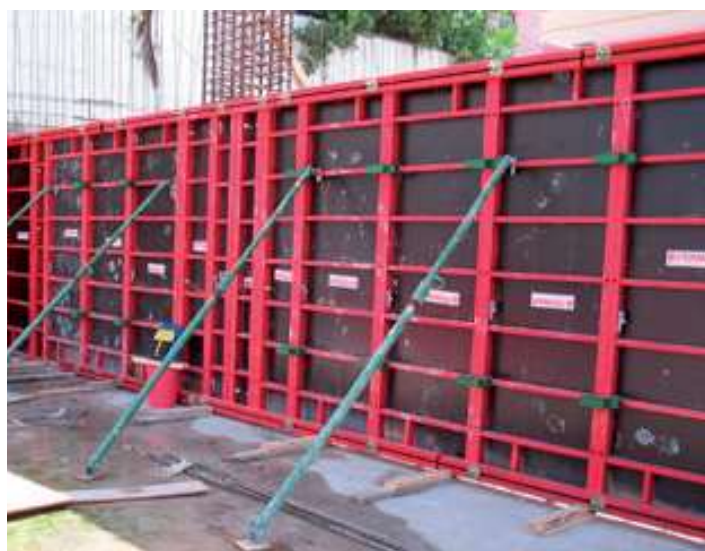
Muro de panel de encofrado fenólico modelo NESS con alienadores en la parte superior e inferior.
