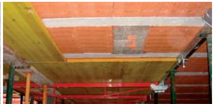
Desencofrado sin reapuntamiento / Un-formwork without props reinforcement / Re-coffrage sans étaieement
