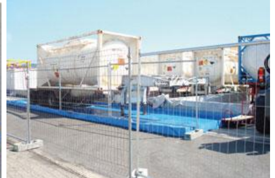
bac de rétention souple 24 000 litres
