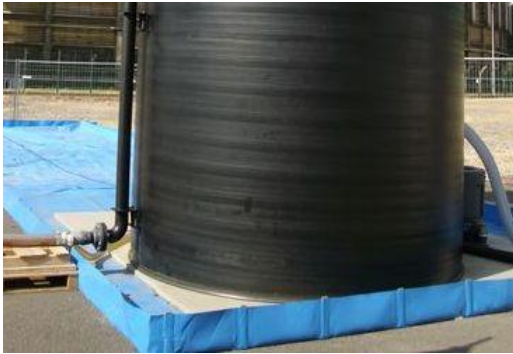
bac pour cuve sur chantier
