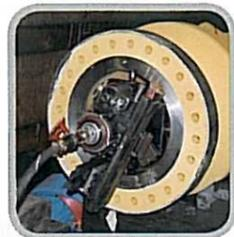
Reprise de portée de joint sur connecteur pipe-line (plate-forme de forage)
