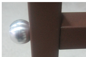
Système de liaison traverse/poteaux
