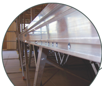
Profilé multifonctions à 2 niveaux de fixation et indexeurs
