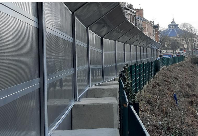
L'absorption acoustique est assurée par un panneau de laine de roche, épaisseur 50 mm, densité 70 kg/m<sup>3</sup>
