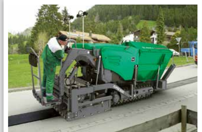
FERMETURE DE TRANCHÉES DE CANALISATION
