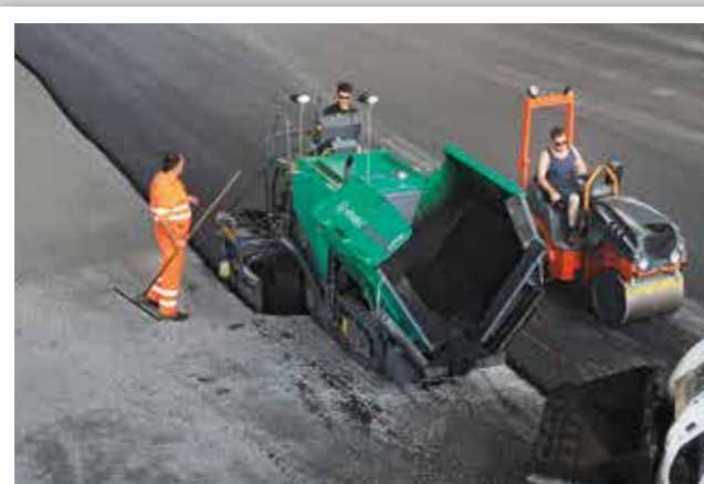
POSE D'ENROBÉ SUR DES TERRAINS DE SPORT
