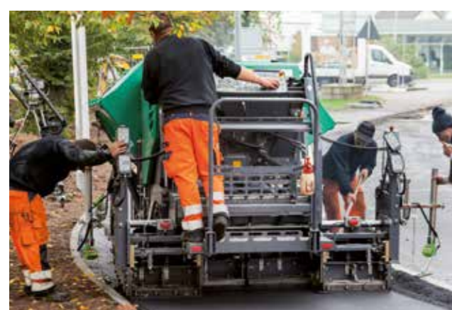
CONSTRUCTION DE CHEMINS RURAUX
