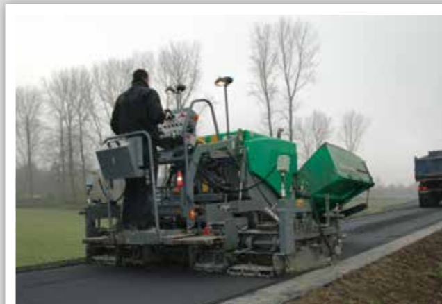
POSE D'ENROBÉ SUR DES DIGUES
