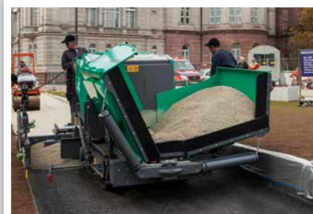
CONSTRUCTION DE PISTES CYCLABLES ET DE VOIES PIÉTONNES
