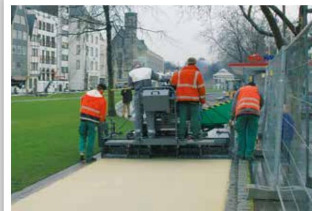
CONSTRUCTION DE CHEMINS EN ESPACES VERTS
