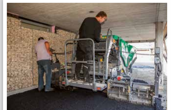
POSE D'ENROBÉ DANS DES HALLES INDUSTRIELLES
