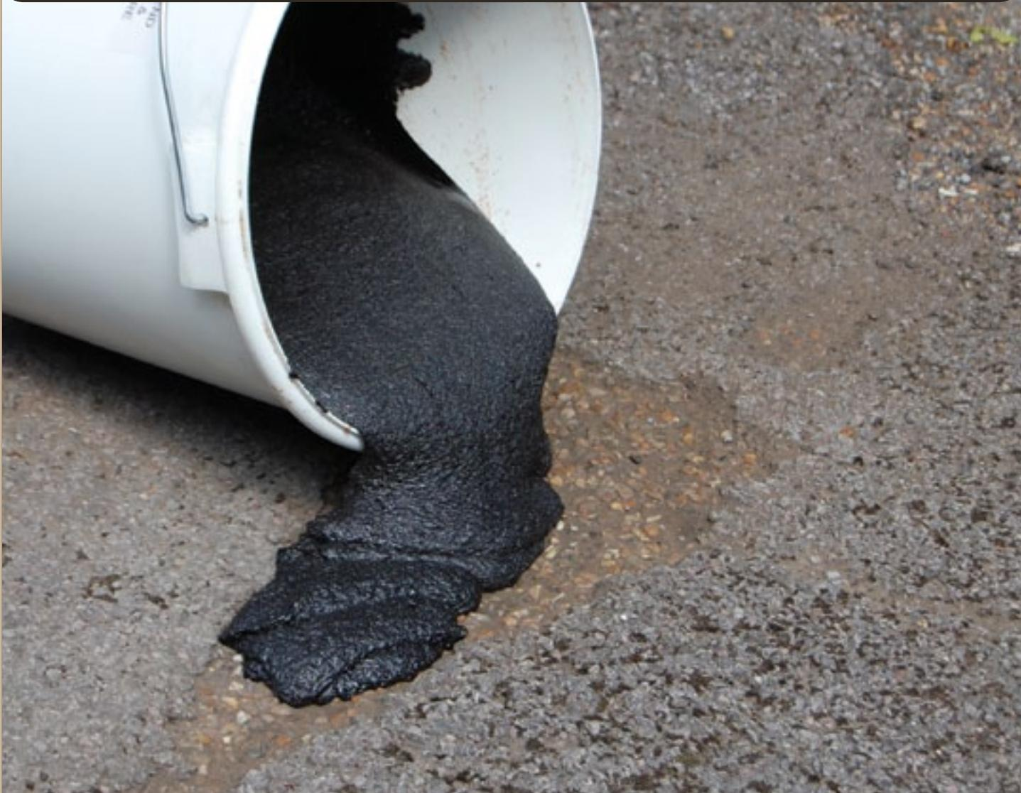
Le Répar'bitume® Coulable est idéal pour les réparations superficielles sur les surfaces en bitume abimées et fissurées. Mélangez simplement le produit et versez sur la zone à réparer. Le produit s'autonivelle et s'étale à l'aide d'une truelle ou d'un platoir. Le kit contient des agrégats de finition en granite à saupoudrer sur la surface afin d'obtenir une finition antidérapante qui se fond parfaitement avec le substrat.
