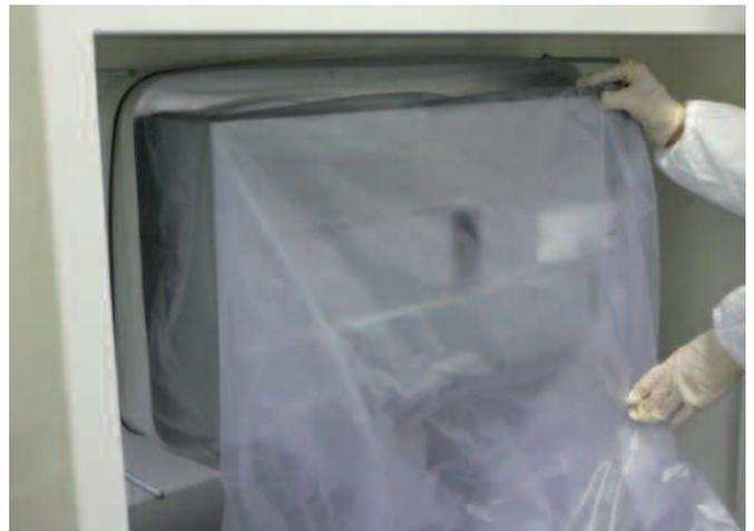
La **maintenance** du filtre de piètement s'effectue **sans contact** du personnel avec le filtre grâce au sachet plastique adaptable.
