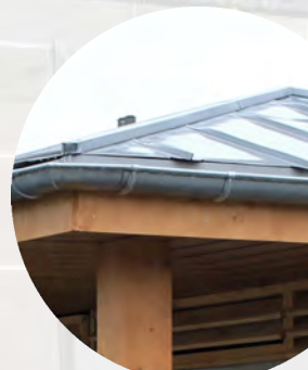
TOIT A 4 PANS EN ZINC
