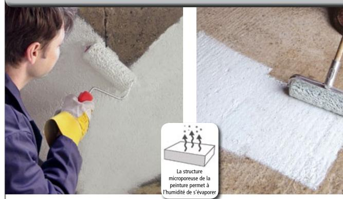
Humidi'stop Premium est une peinture hydrofuge, pénétrante, à base de résine époxy en dispersion aqueuse, destinée à être utilisée sur les murs intérieurs et les sols à trafic léger. Watco Humidi'stop Premium procure une surface résistante à l'usure et aux produits chimiques et contient un fongicide efficace.
