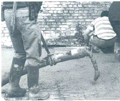
Pompage de béton
