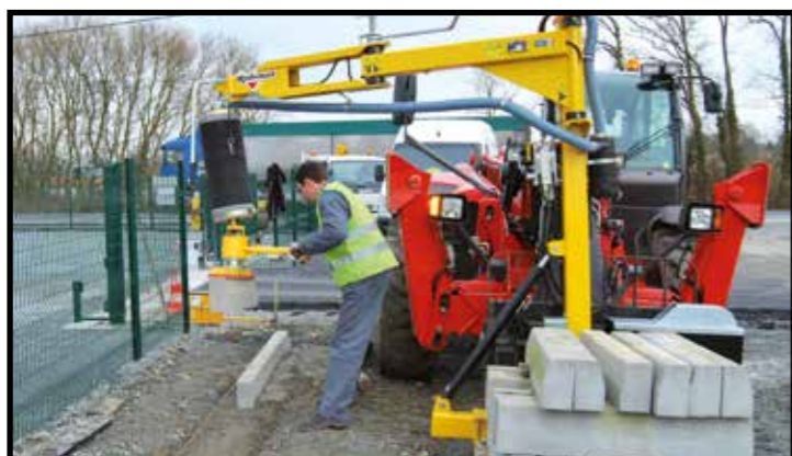
POSE-BORDURES adaptables sur tout engin hydraulique avec fourches. - Modèles avec commande électrique ou par aspiration par vide d'air. - Pose tous types de bordures (béton, granit...) - La palette de bordures est transportée directement sur la fourche.
