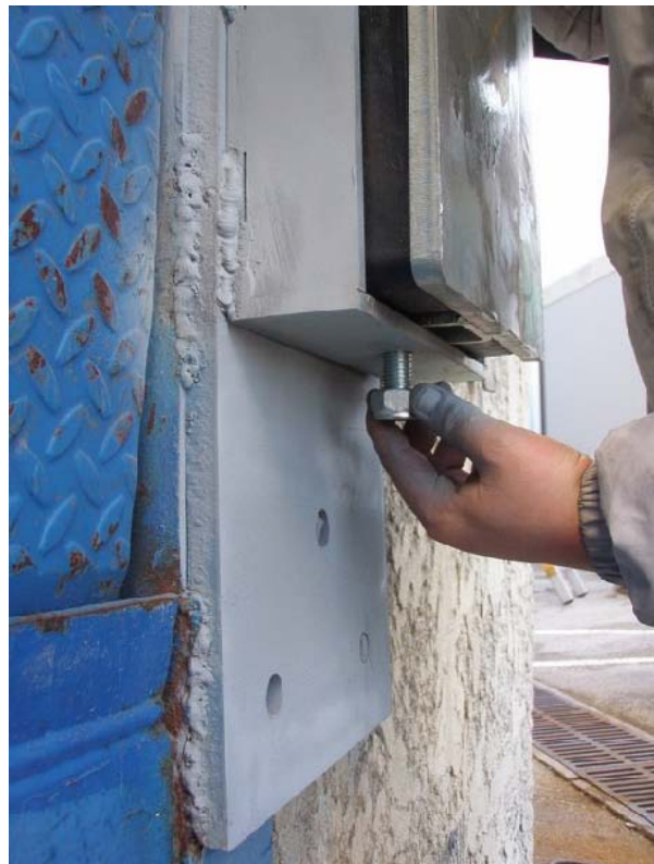
Fixation du capot mobile avant par une tige filetée verticale de fort diamètre
