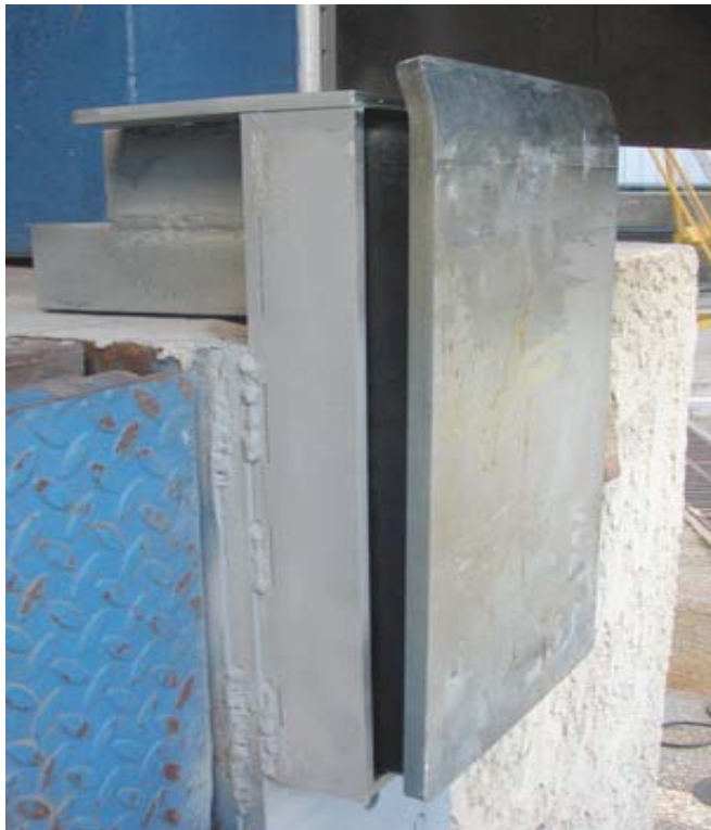
Butoirs posés rehaussés sur profil métallique pour recevoir des Containers
