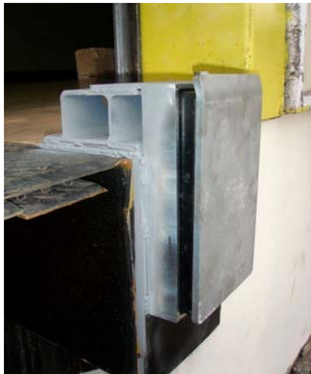
Butoirs posés rehaussés sur profil métallique pour recevoir des Containers
