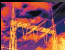
Inspection de lignes à haute tension
