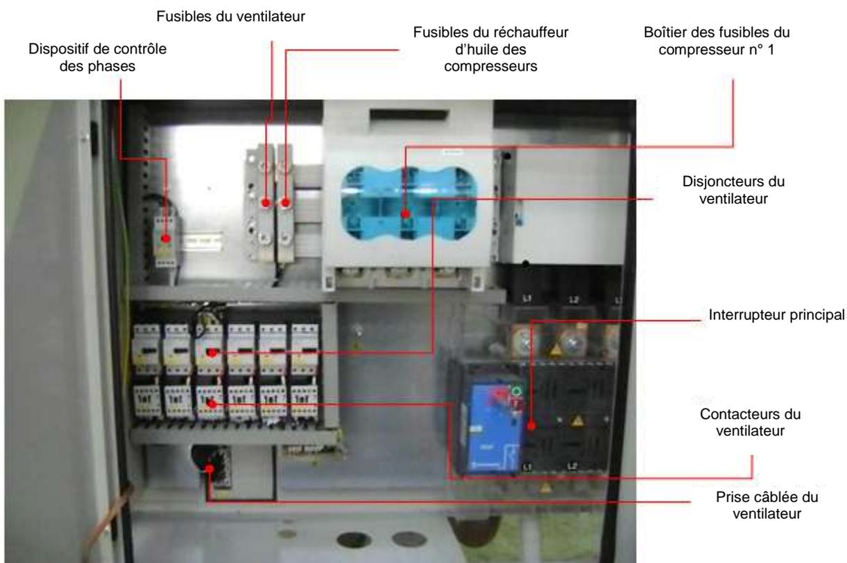
**Figure 3 : tableau électrique, côté droit**
