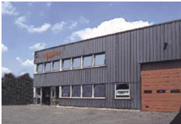
Bureaux et magasins à Villepinte.
