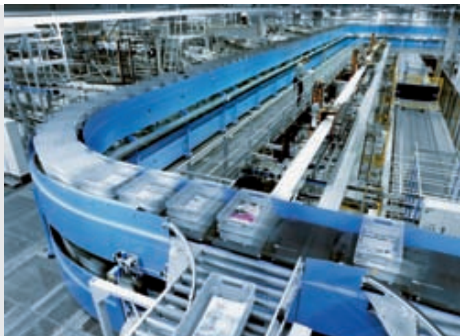
Trieuse horizontale (structure en anneau)
