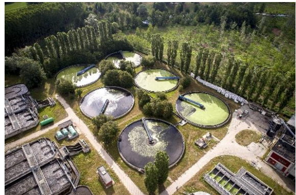
Extraction de polluants dans les stations d'épuration
